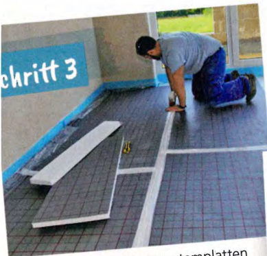
Verlegung der Tackersystemplatten und Verkleben der Plattenstöße
