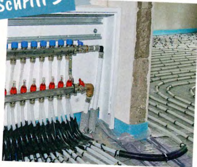
Durchführung der abschließenden Druckprobe
