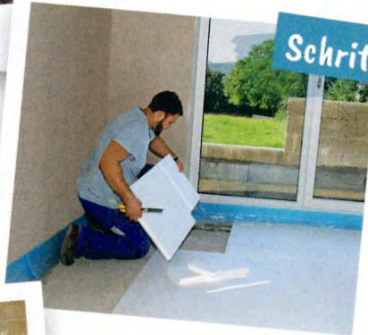
Verlegung der Zusatzdämmung
