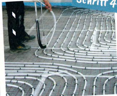
Heizrohrverlegung in Schneckenform
