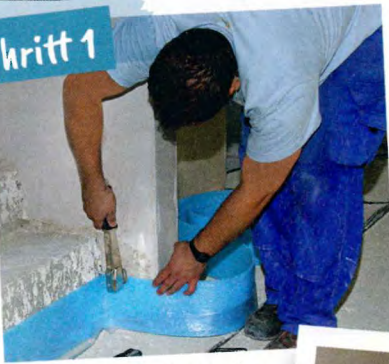
Befestigung des Randdämmstreifens
